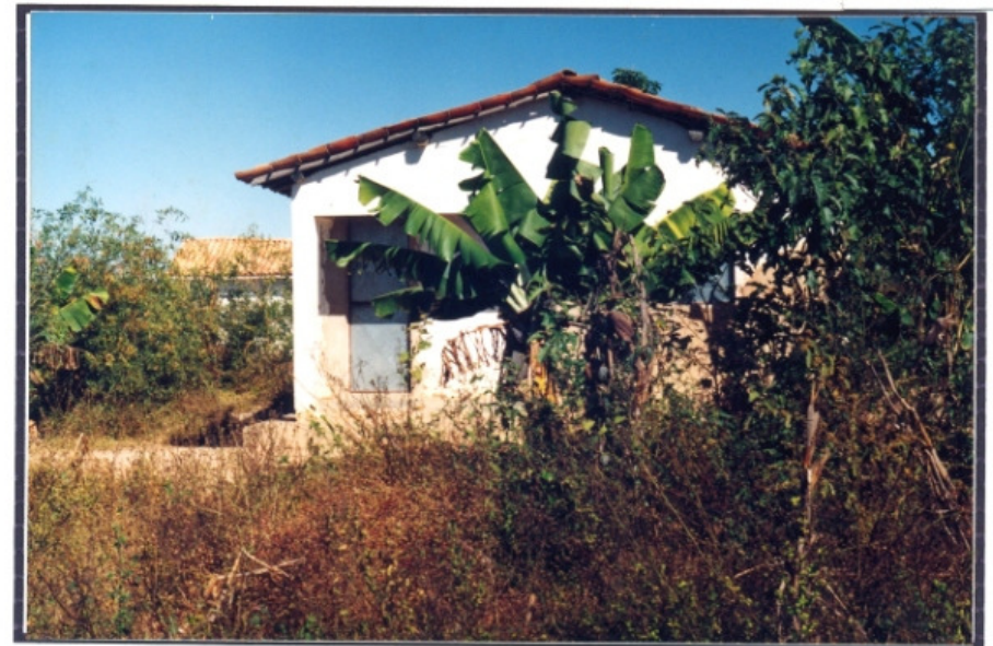
1999 (Depois da reforma realizada pela Fundação Nacional de Saúde/Correntina, entre 1993 e 1994)
